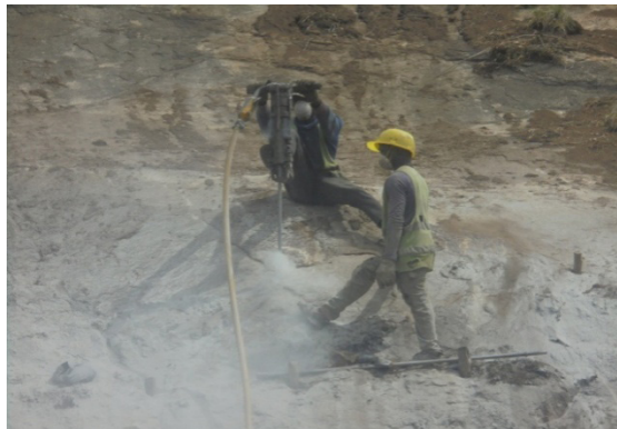
Figura 7 – Poeira e processo da perfuração da rocha usando precursor manual.
